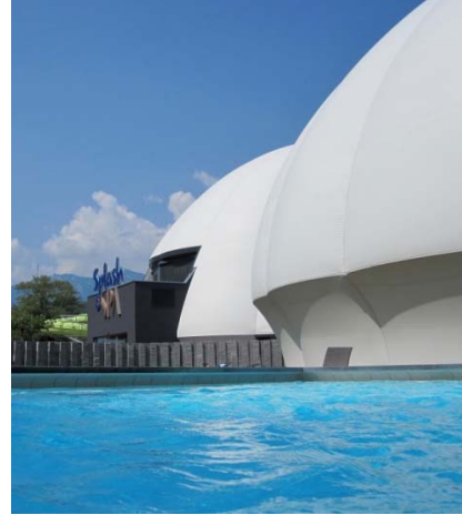
Wellness- und Rutschbahnkuppel Foto: 1864a
