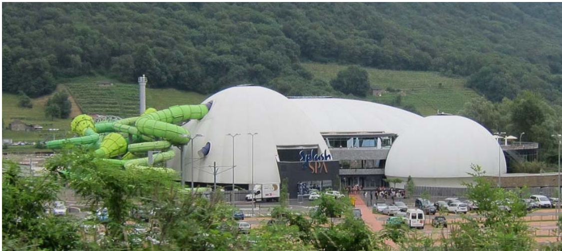
Die drei Kuppelbauten prägen die Gestalt des Splash & Spa Tamaro von außen. Foto: IMG_5327
