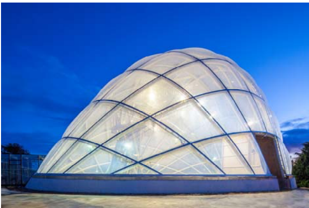
Die ETFE-Kissen sind teilweise mit einer integrierten pneumatischen Verschattung versehen.
